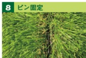
8 ピン固定 パイルを挟まないように注意しながら固定 (10本/m 2 )
