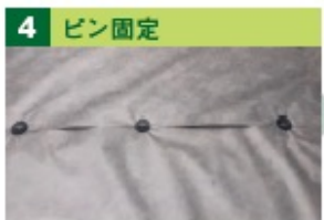
4 ピン固定 コの字ピン (2.5本/m 2 ) で固定
