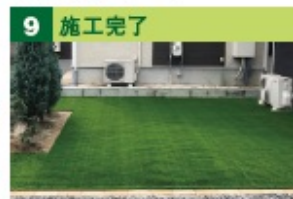
9 施工完了 デッキブラシなどでパイルを立てさせて完成
