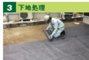
3 下地処理 地面に防草シート「KOMA100EX」を設置
