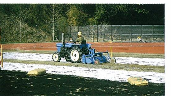
【写真-33】トラクターによる攪拌
